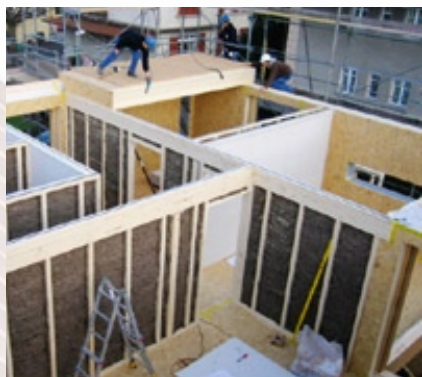
Elementbauweise mit 40 Zentimeter dicker Schafwolle-Wärmedämmung.
